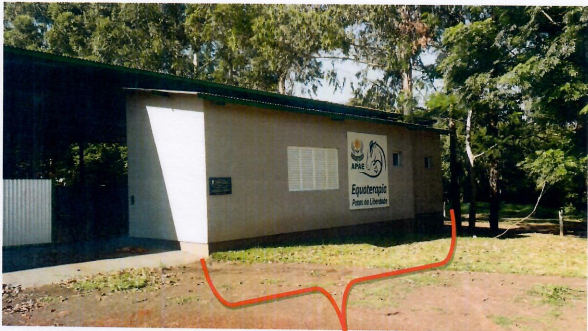
AMPLIAÇÃO DE EDIFICAÇÃO DE APOIO AS ATIVIDADES DA EQUOTERAPIA COM CONSTRUÇÃO DE SALA DE ATENDIMENTO E TRÊS BANHEIROS.
