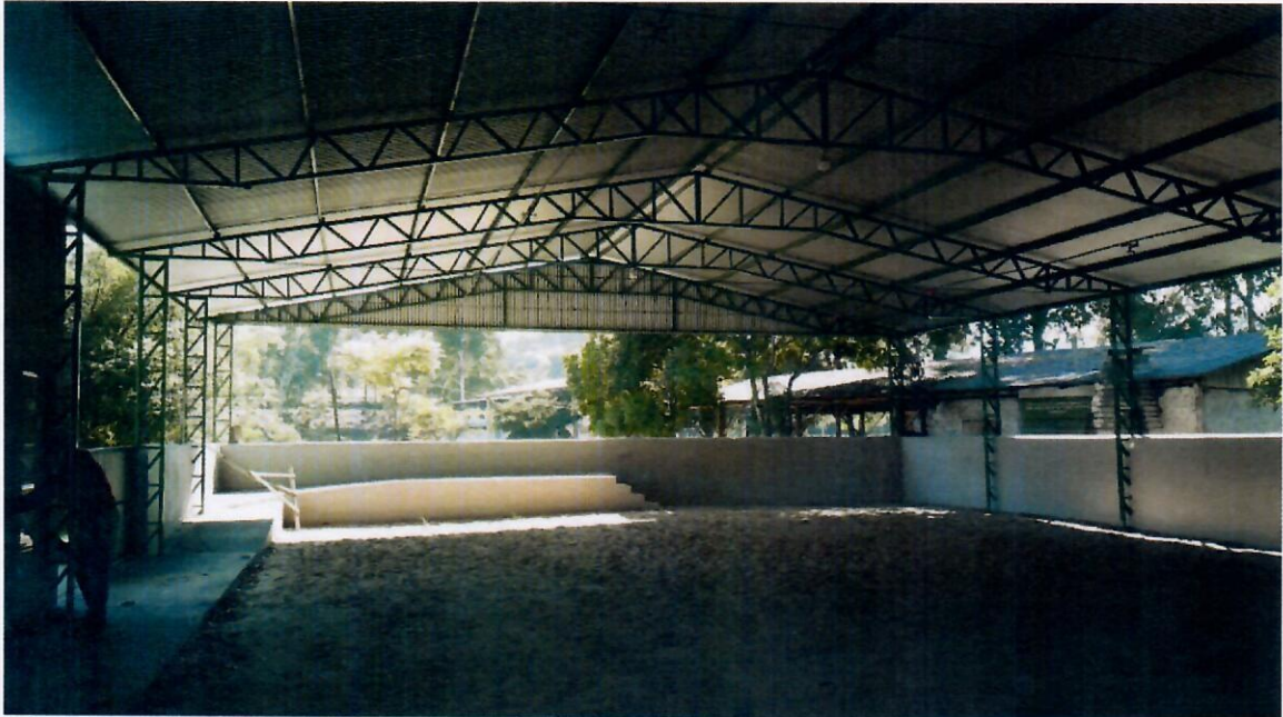
VISTA INTERNA DA AMPLIAÇÃO
